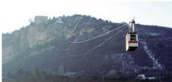
Situazione attuale La funivia che dal fondovalle conduce a Sardagna
